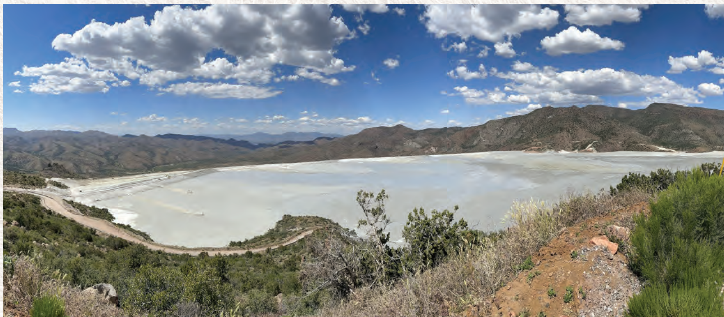
Instalación de almacenamiento de relaves, Pinto Valley
