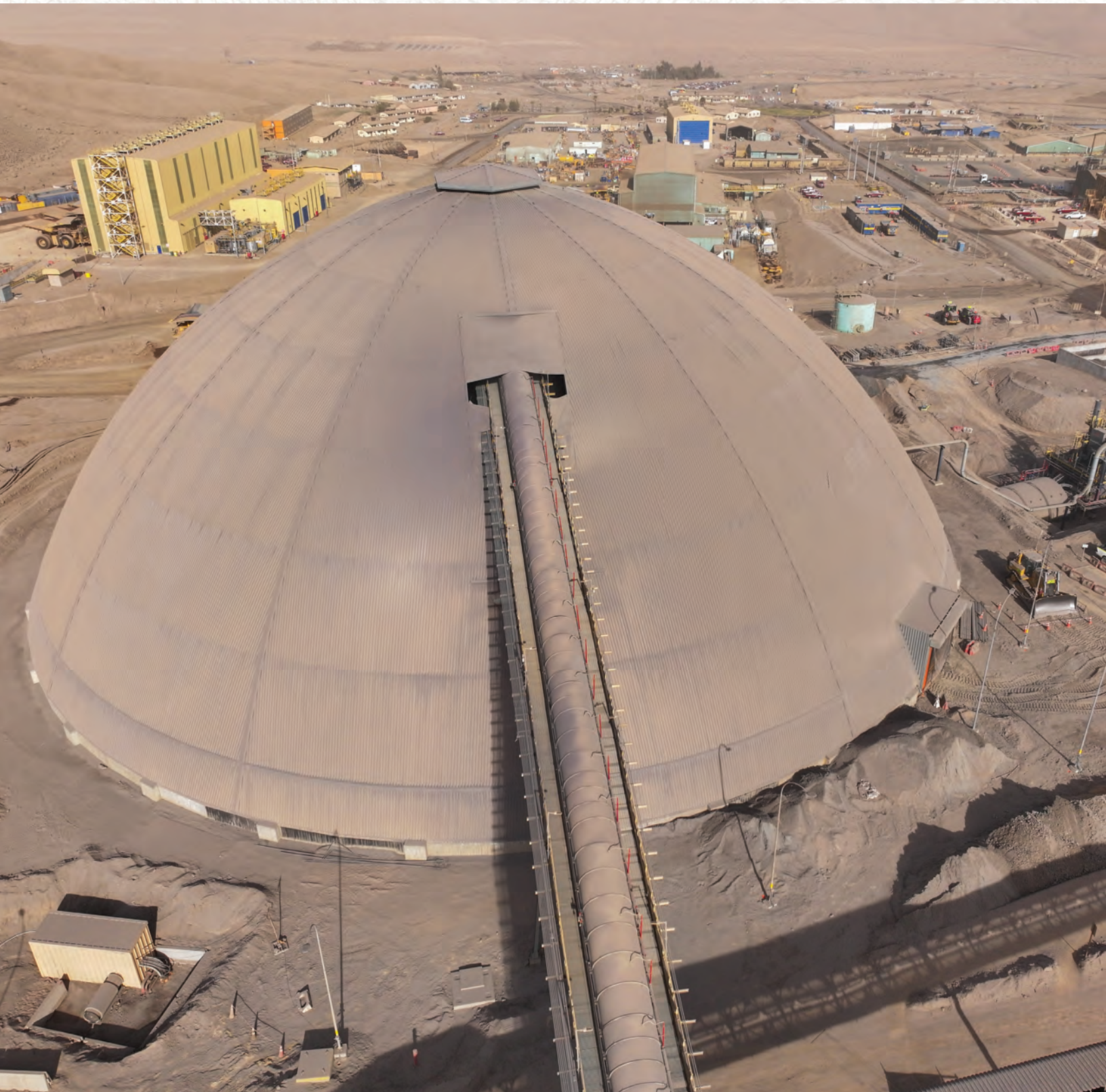
Depósito cubierto de mineral grueso, Mantoverde
