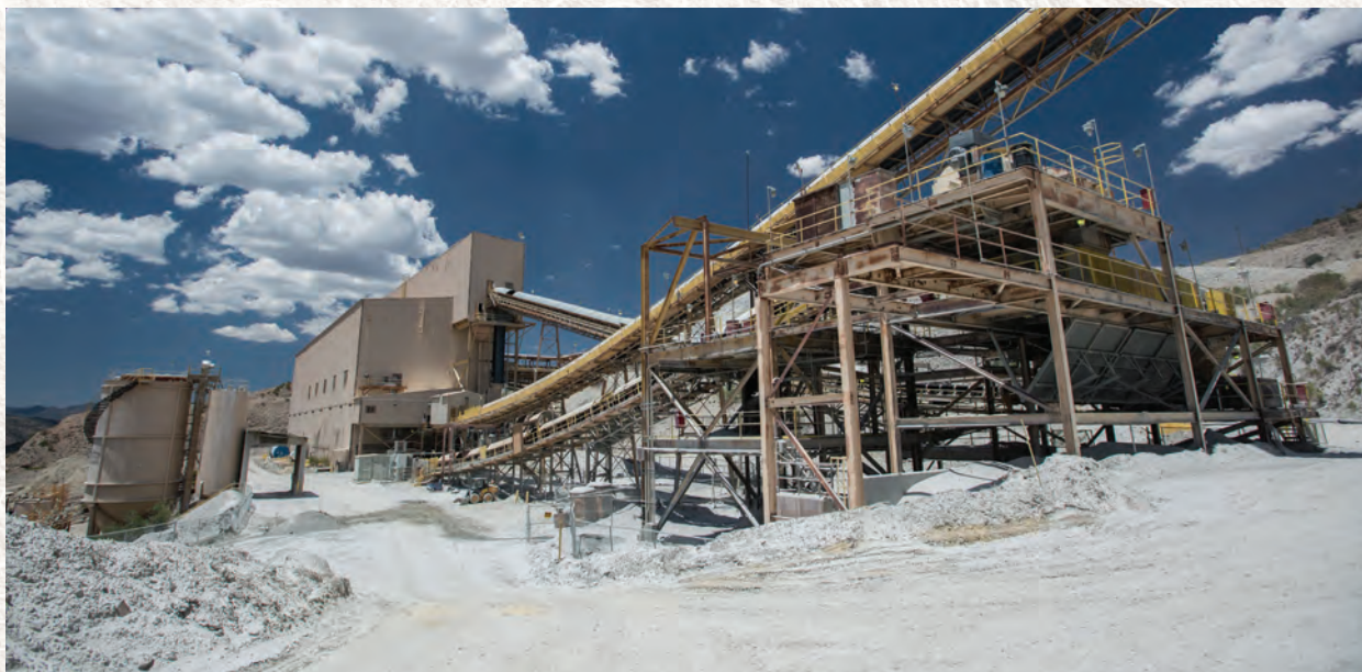
Circuito secundario de chancado, Pinto Valley
