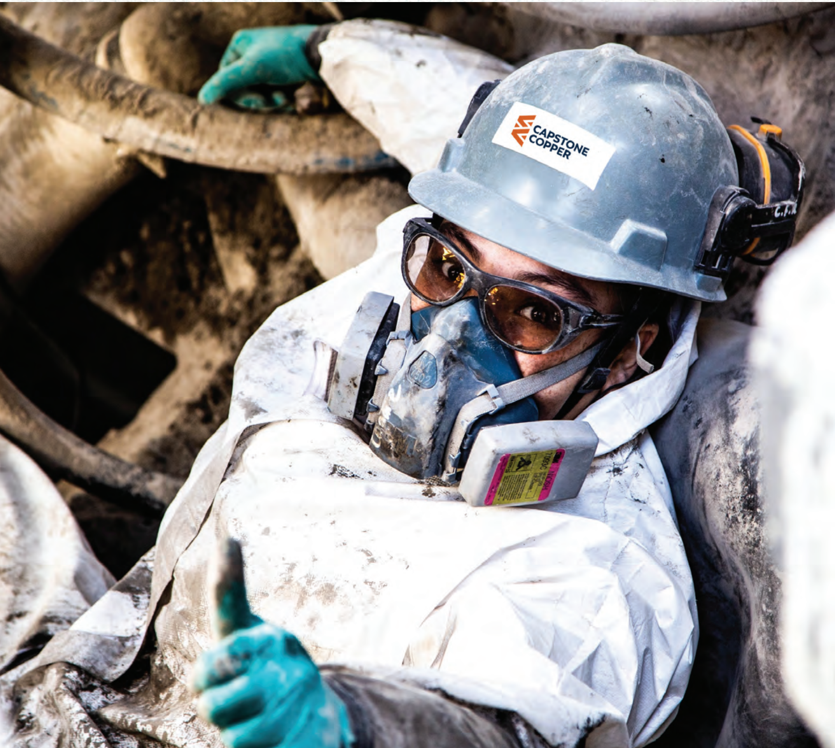
Mantenimiento mecánico de planta, Mantos Blancos
