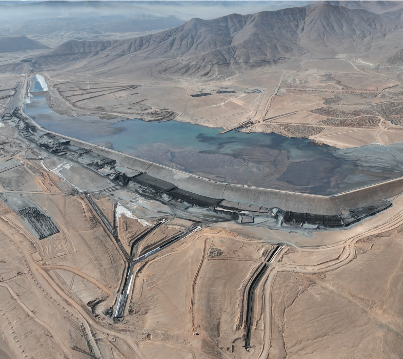
Nueva instalación de almacenamiento de relaves, Mantoverde
