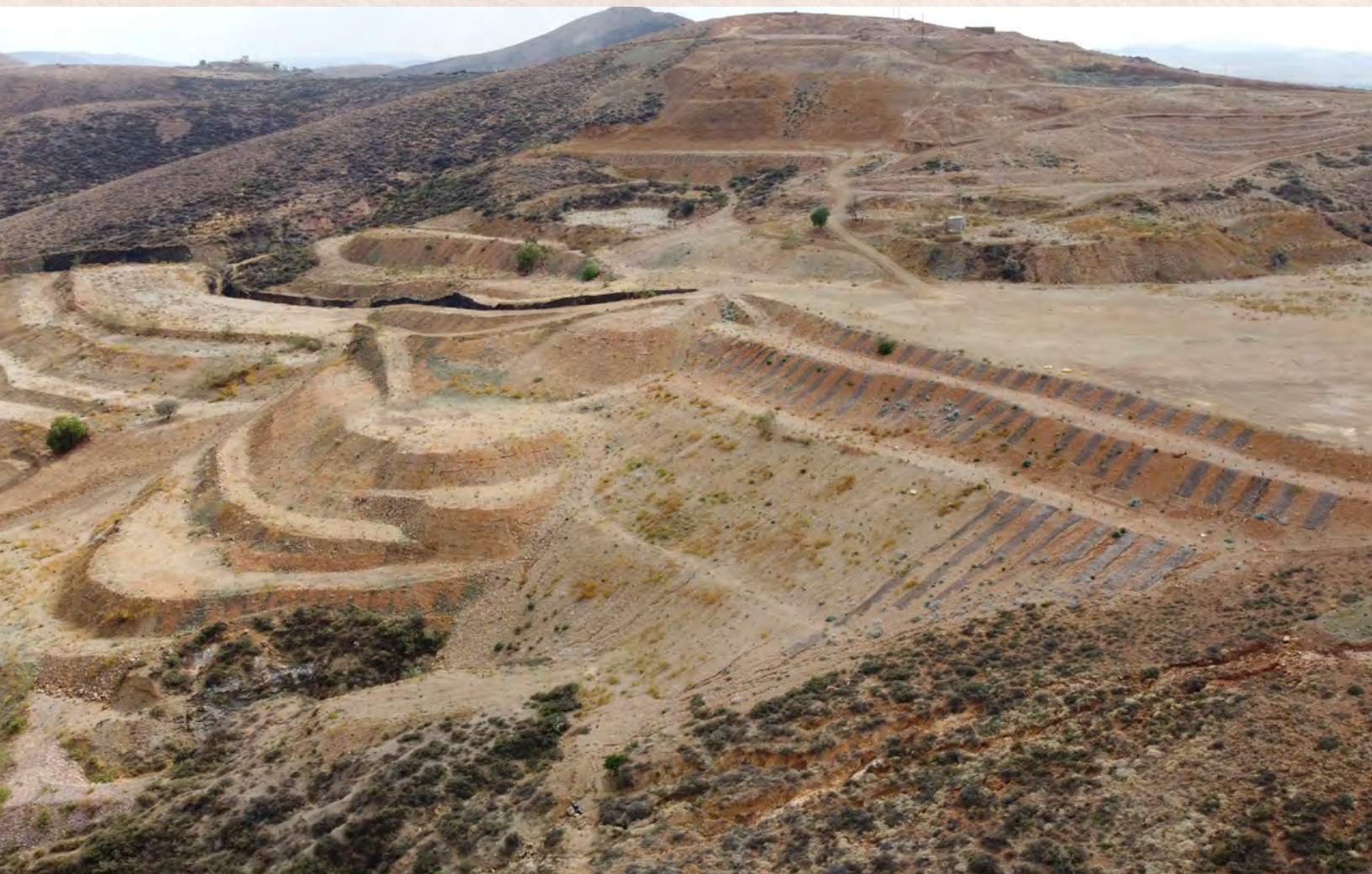
Cozamin – rehabilitación de la instalación de almacenamiento de relaves Chiripa.
