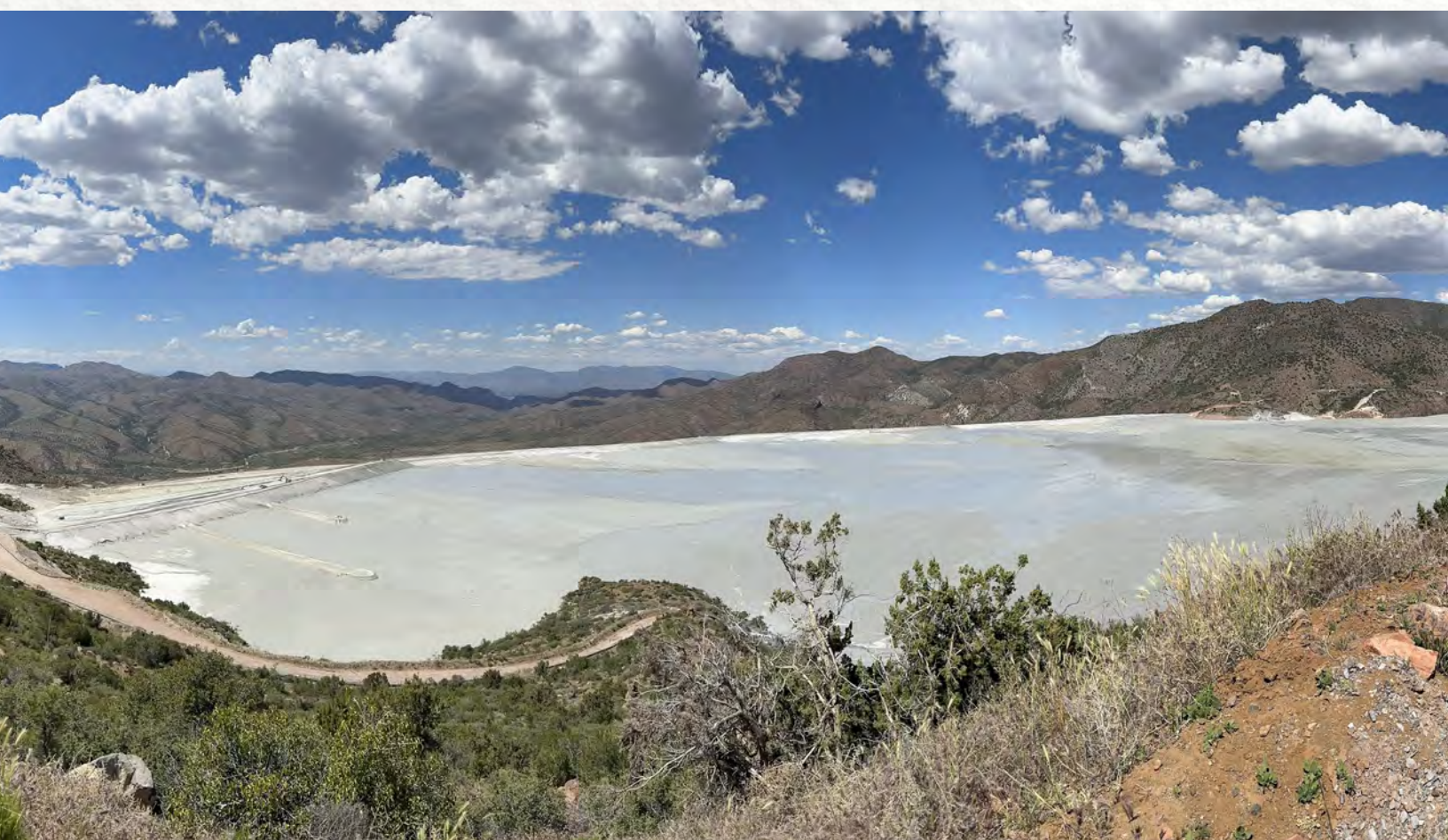
Pinto Valley – instalación de almacenamiento de relaves.
