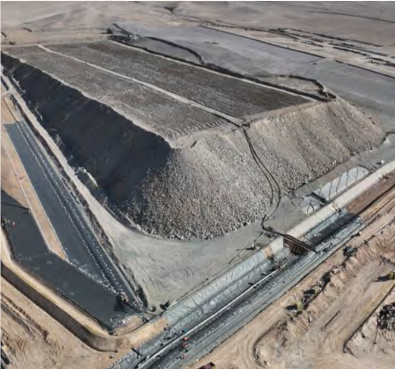
Mantos Blancos – puesta en marcha del Dump Este Fase 1.
