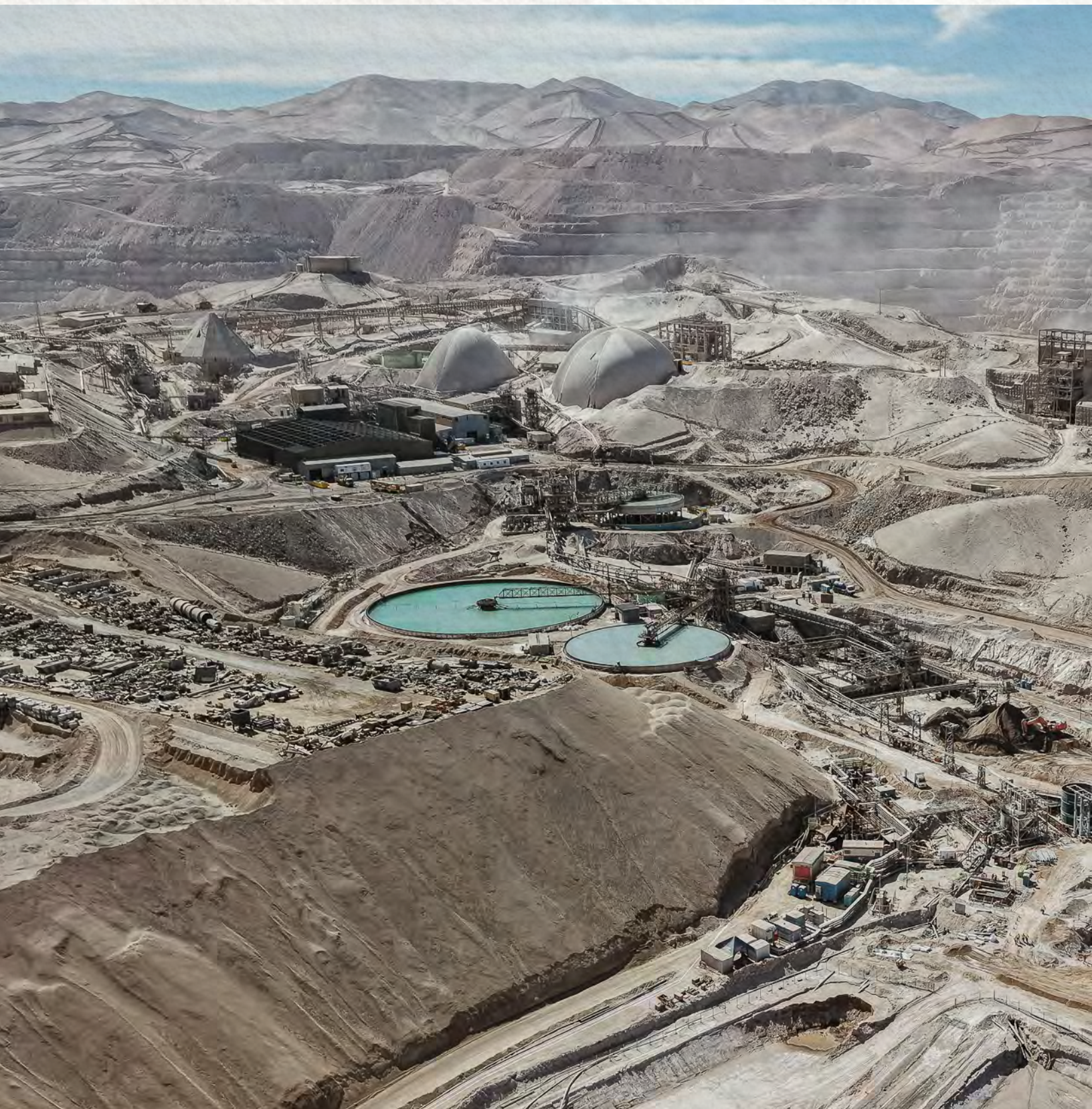
Mantos Blancos – vista general.
