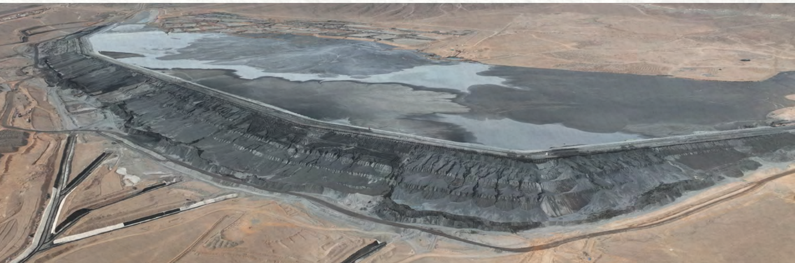
Instalación de almacenamiento de relaves de Mantoverde – construcción del muro de arena.
