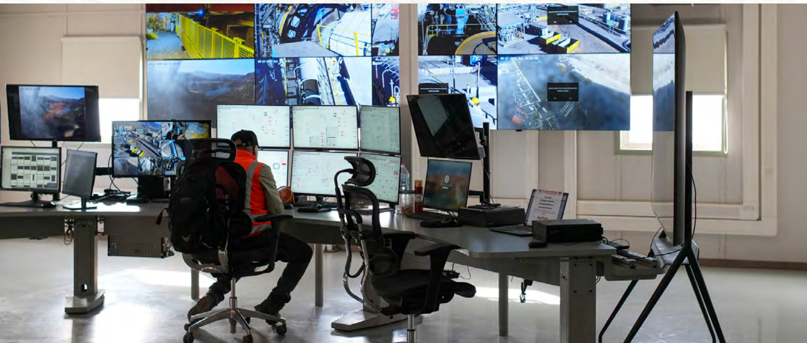
Mantoverde – sala de control de la planta concentradora.
