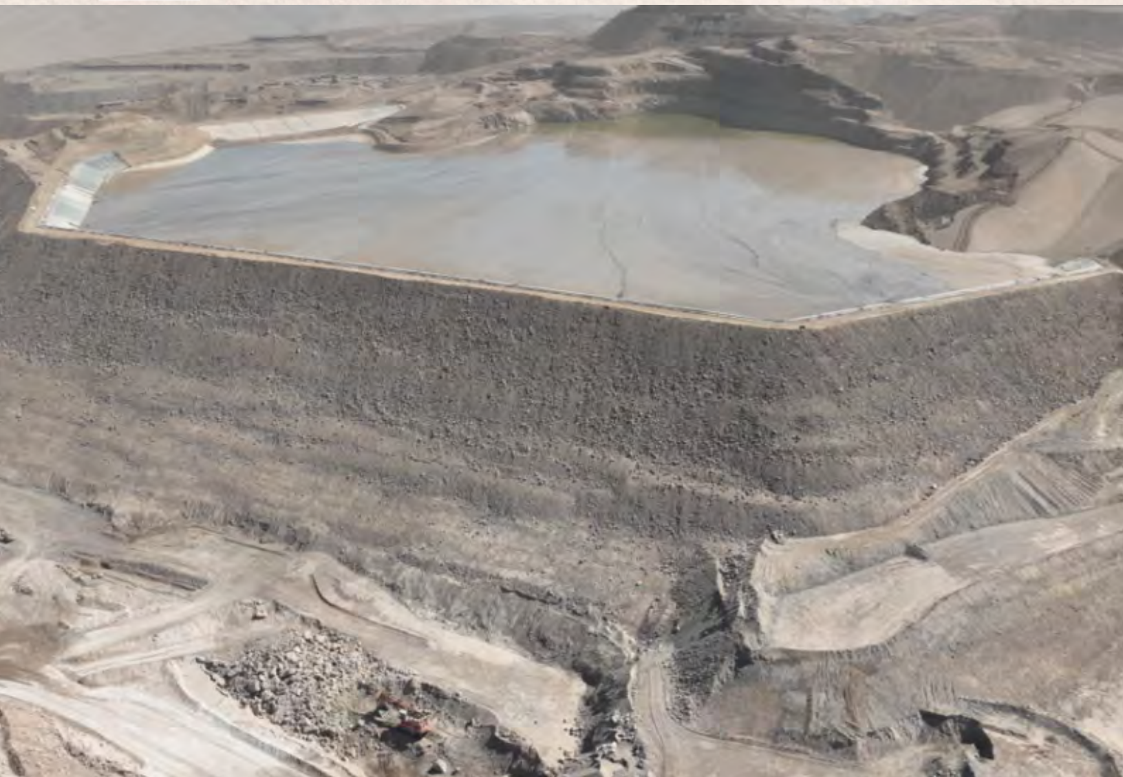
Mantos Blancos – Pit Fase 8, construcción de la Etapa 4.
