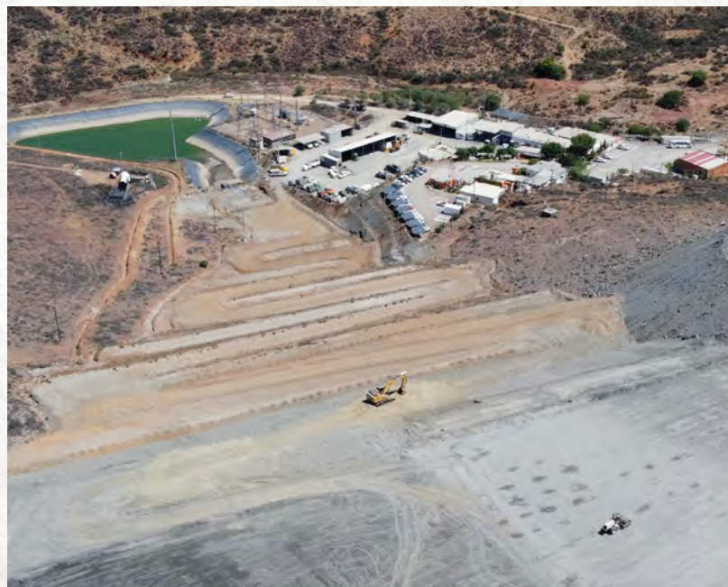
Cozamin - instalación de almacenamiento de relaves Fase 1 con rehabilitación parcial.
